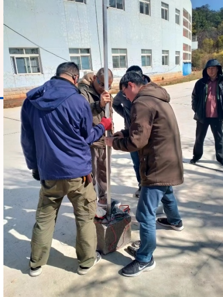
做不裂的位置正确的水泥墩
