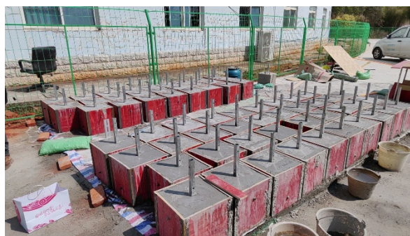
做不裂的位置正确的水泥墩
